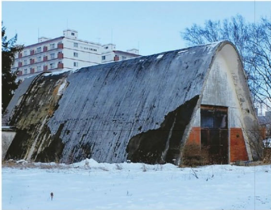
市が解体した収蔵庫
