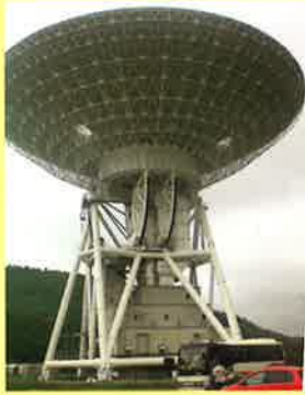
JAXA臼田宇宙空間観測所の直径64mの巨大パラボラアンテナ。このアンテナで、あの「はやぶさ」とも交信していました。
