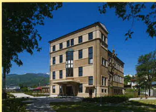
伊那市創造館(旧上伊那図書館)(1930・伊那市) 基本設計 森山松之助 実施設計 黒田好造
