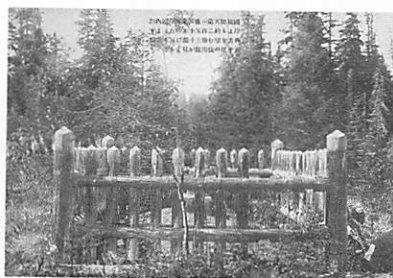
国境標点第一号（東海岸遠内海岸より約二百五十米の点）より西方を望む巾三十間に亘る北緯五十度の伐開線が見える
